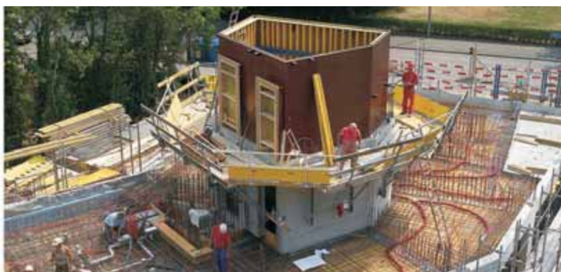
Abb. 3.2: Einsatz von Schalungsplatten aus Sperrholz im Hochbau
