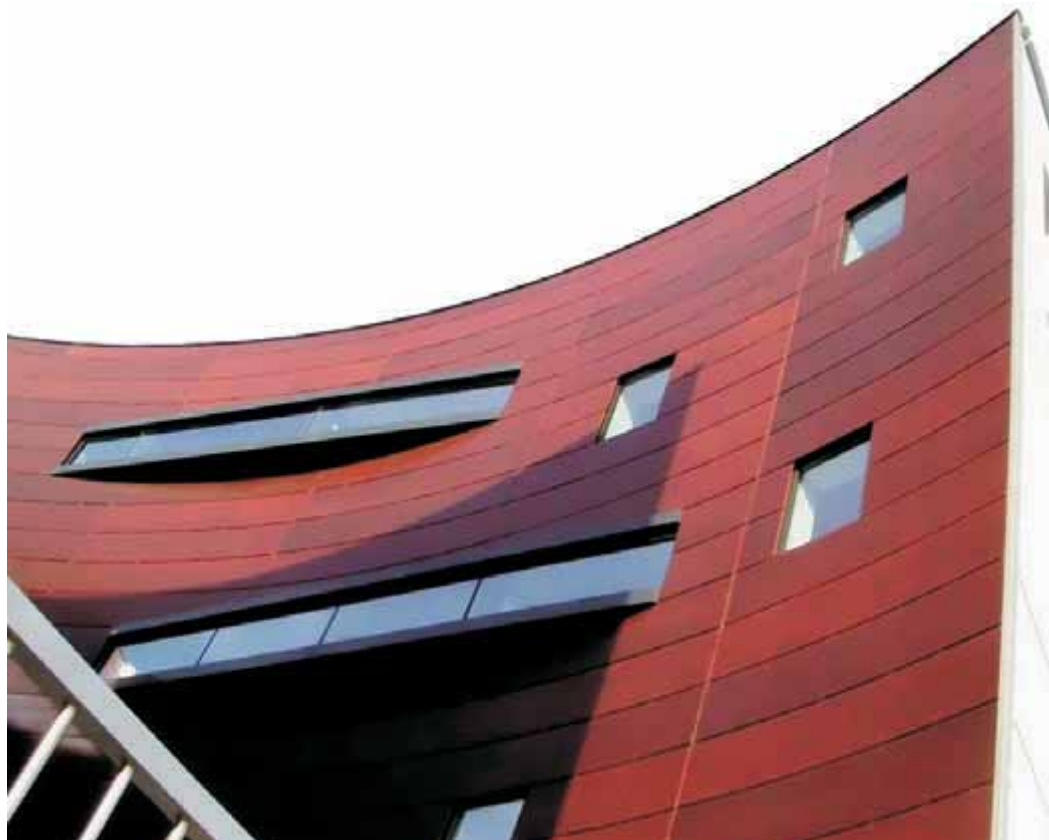
Abb. 3.3: Fassade aus Sperrholz
