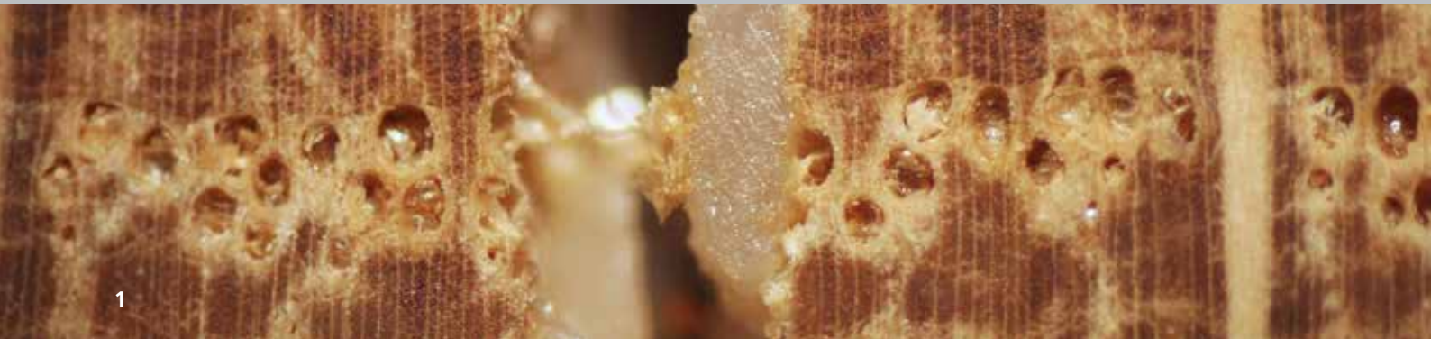
1 Delaminierte Melamin-Harz-Klebfuge in Eichen-Brettschichtholz.
